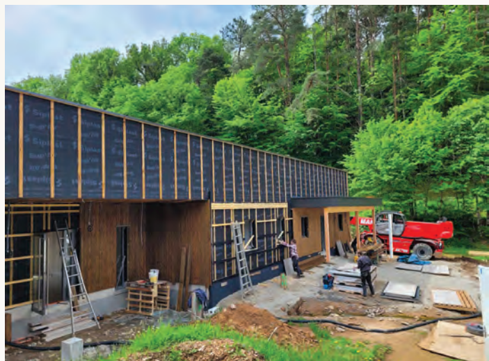
Travaux de la Maison des Assistantes Maternelles
