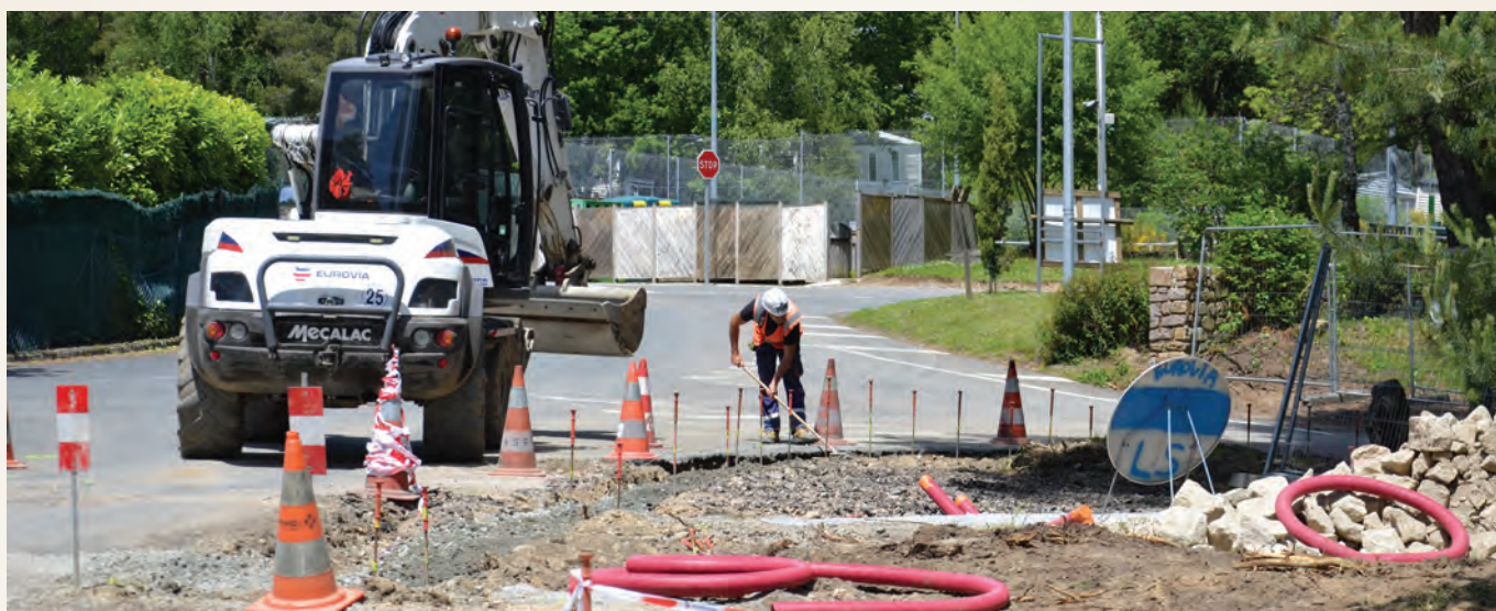
Travaux à Miel
