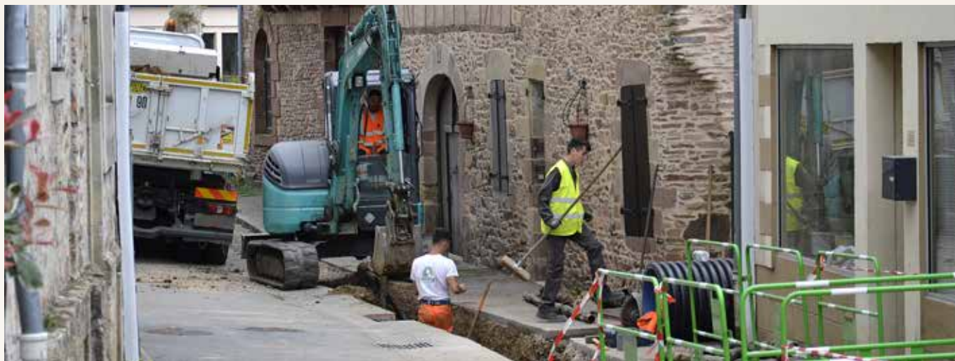
Les travaux de mise en place du réseau de chaleur
