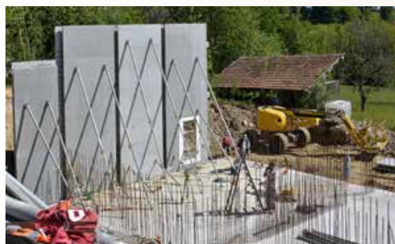
La chaufferie bois en construction
