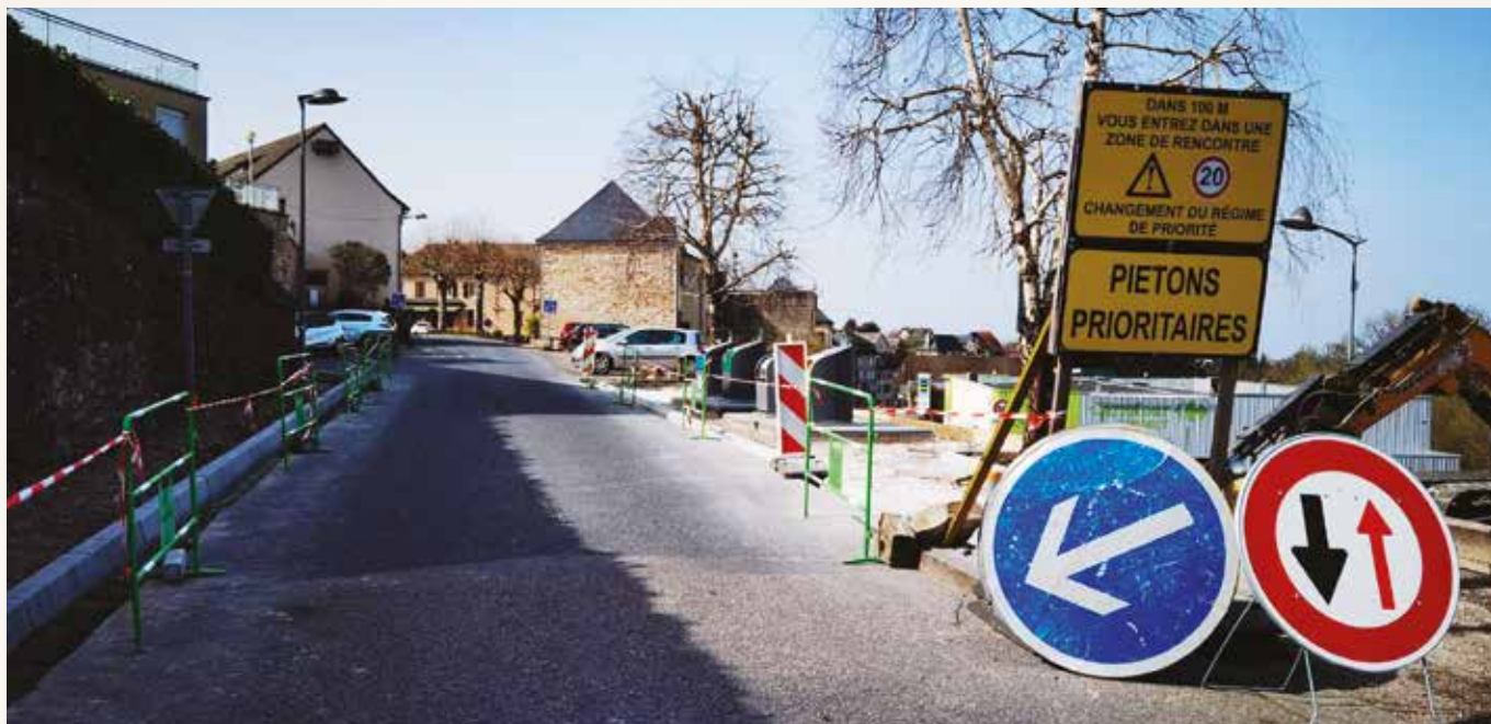
Travaux d'aménagement et de sécurisation de la zone de rencontre
