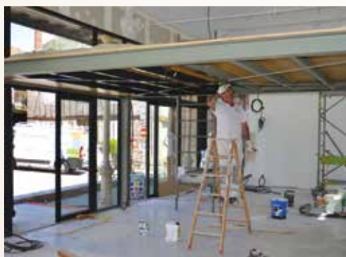
Travaux de la future médiathèque
