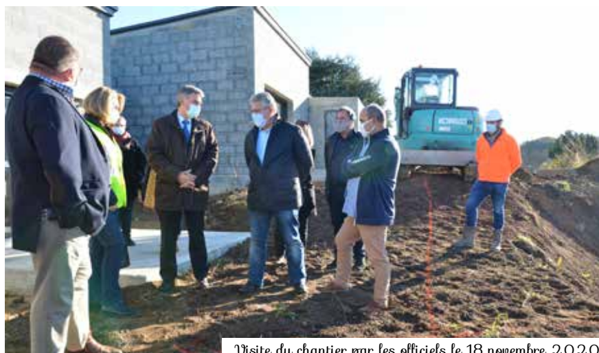
Visite du chantier par les officiels le 18 novembre 2020
