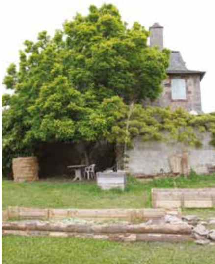
Construction de bacs de jardinage.
