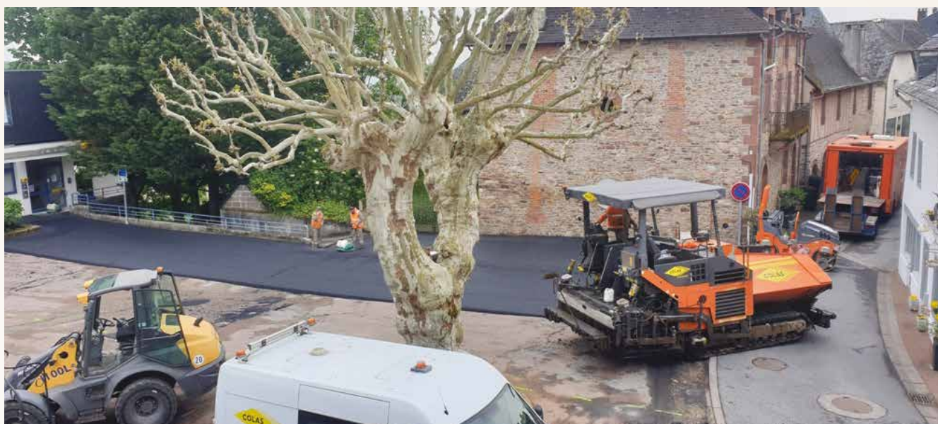
Travaux de surfacage place de la Poste.
