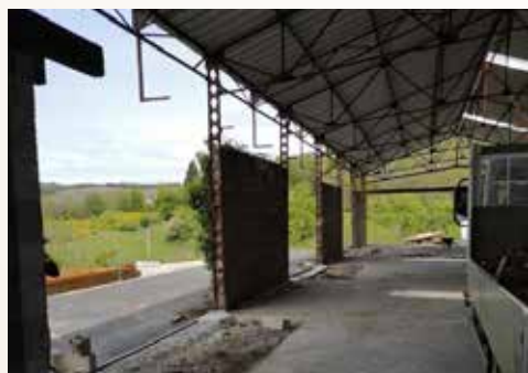
Travaux du futur local technique à la zone du Peuch.
