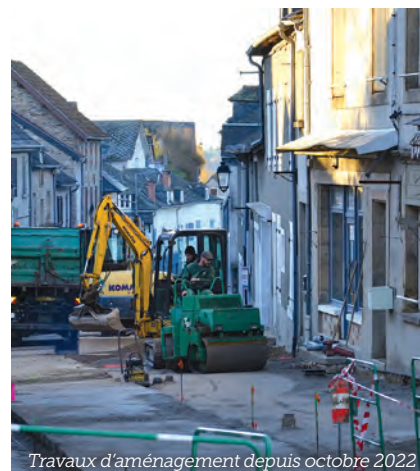
Travaux d'aménagement depuis octobre 2022
