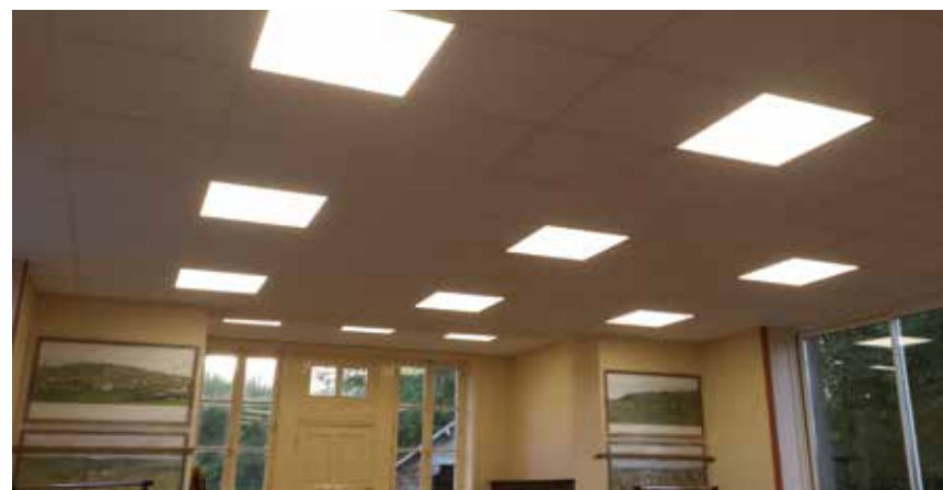
Salle polyvalente du Parjadis - Faux plafond après travaux
